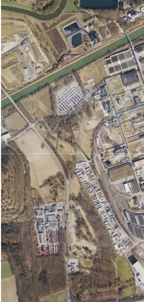
Abbildung: Luftbild Westerweiterung; Quelle Stadt Marl
